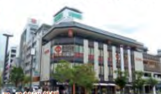
フェスタビル外観
