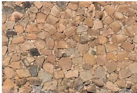
打込接ぎ(大天守)
