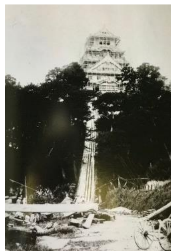
明治の修理(素屋根がない)
