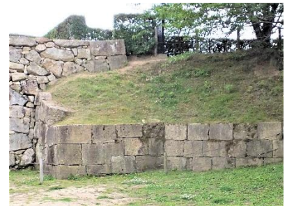
切込接ぎ(武蔵野御殿跡)
